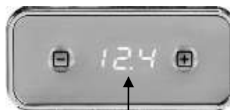
Temperatuur stoom boiler (t2, hier 124°C) -Komma in de 3e positie.
